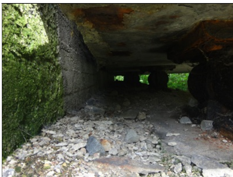
Uspořádání na úložném prahu levobřežní podpěry
