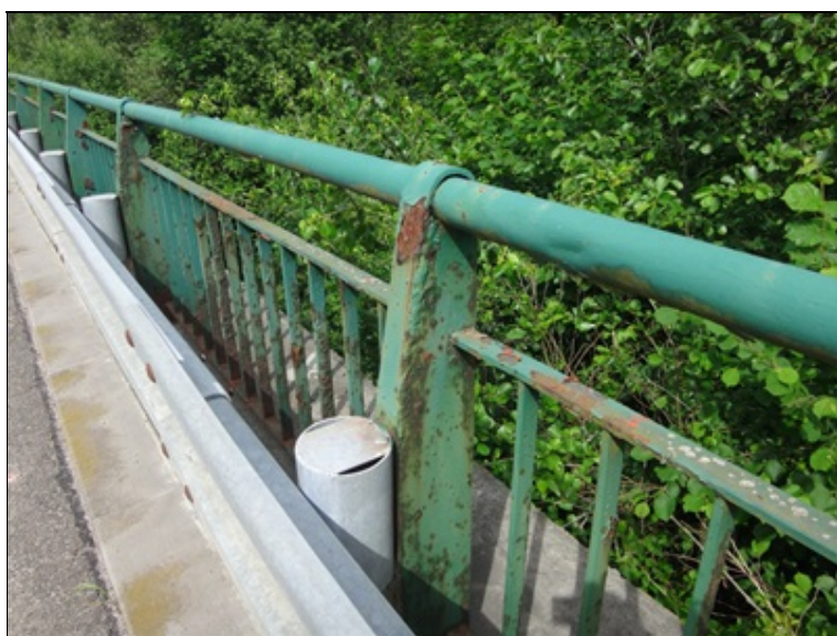
Poruchy PKO zábradelních svodidel
