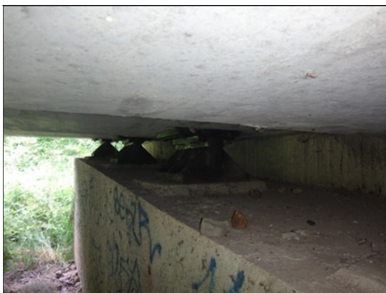
Uspořádání na úložném prahu levobřežní podpěry
