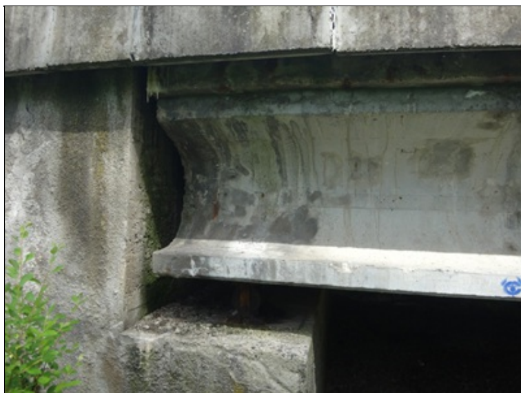
Uspořádání na úložném prahu levobřežní podpěry
