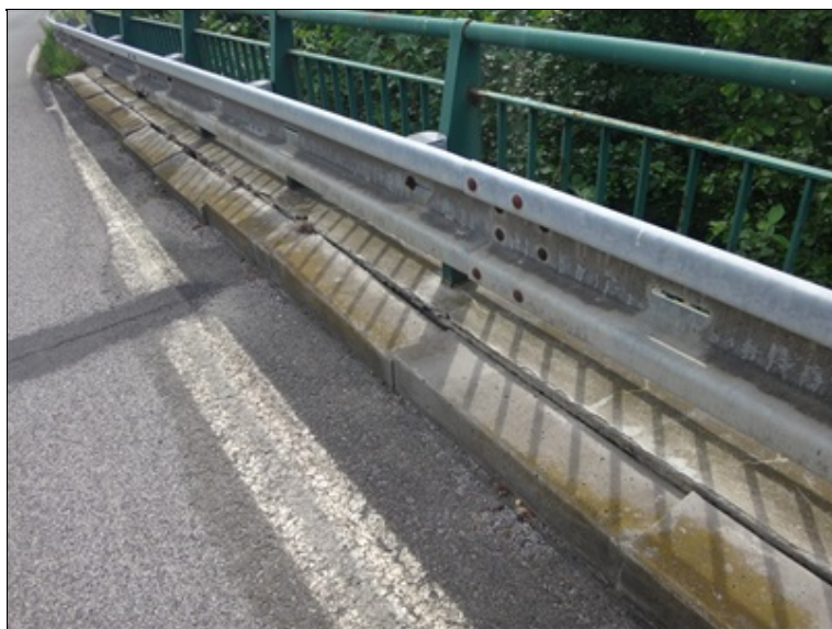
Uvolnění a deformace obrubníků na vtokové římse
