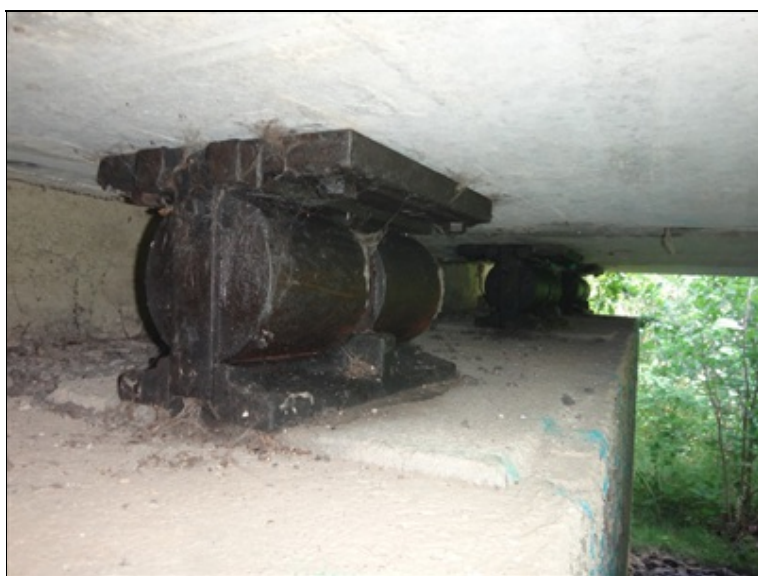
Ložiska na levobřežní podpěře
