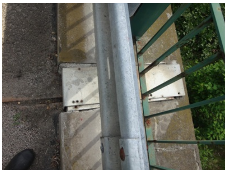
Překrytí MZ v římse nad levobřežní opěrou
